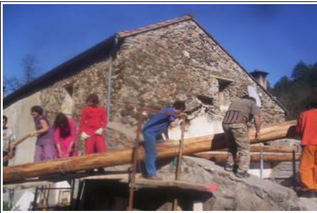
Mise en place de grosses poutres Photos devant un mur en pierre sèche reconstruit
